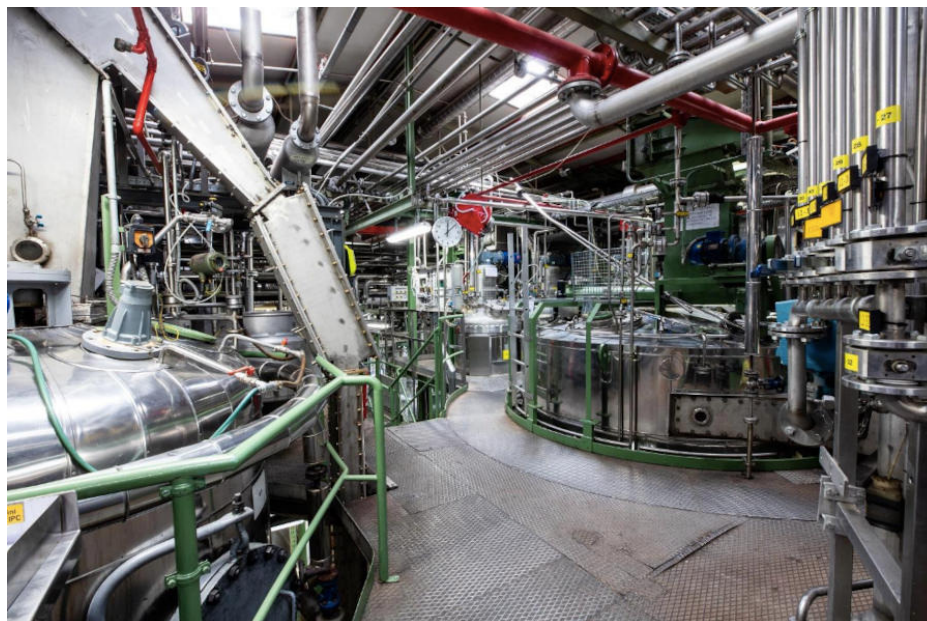
Vista dell'impianto di estrazione con un ordinato labirinto di tubazioni a ciclo chiuso.
