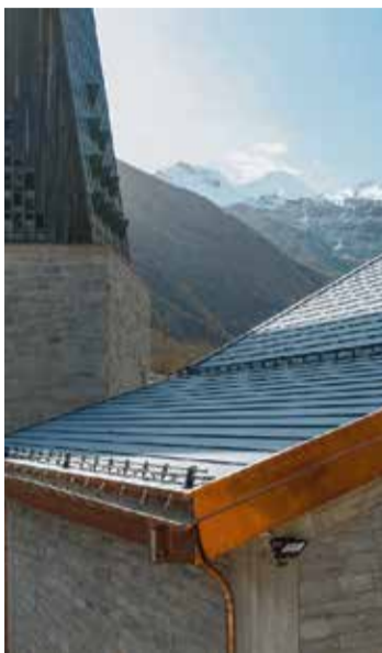
Blick auf die Kirche in Saas-Fee mit einem Solardach von Megasol. Foto: PD
